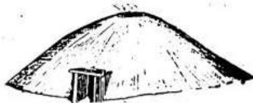
Nhà gỗ đắp đất
