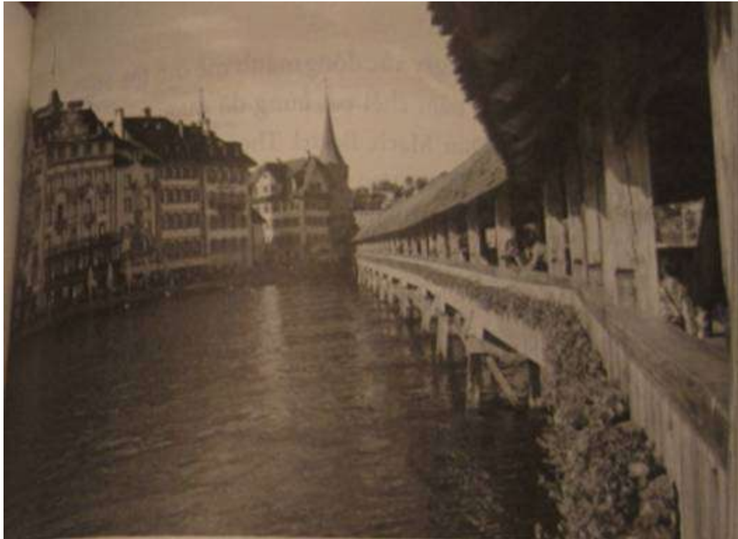
Cận cảnh cầu Kappelbrücke
