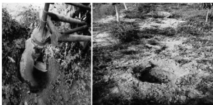
Giàn khoan hố trồng cây đang hoạt động và hố trồng cây đã được đào xong
